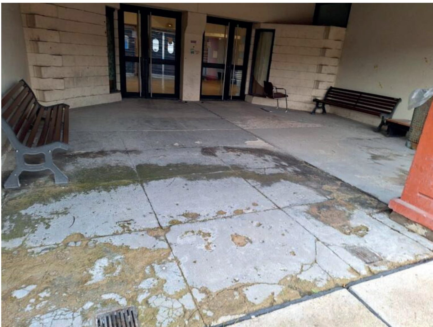
Passerelle entre laboratoire et salles de cours, Université Paris 13, mars 2024
