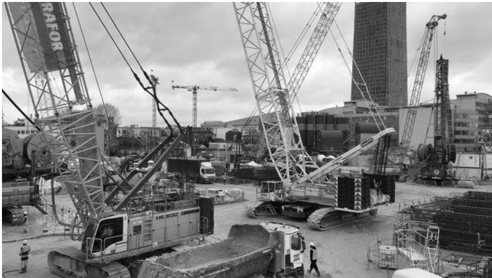
Un des chantiers du Grand Paris
