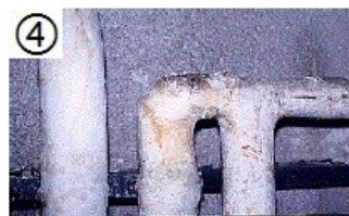
Calorifugeage de tuyaux
