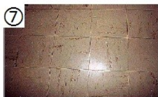
Dalles de sol
