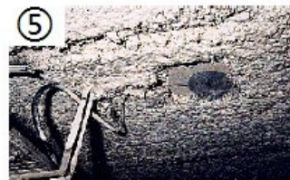
Flocage de plafonds
